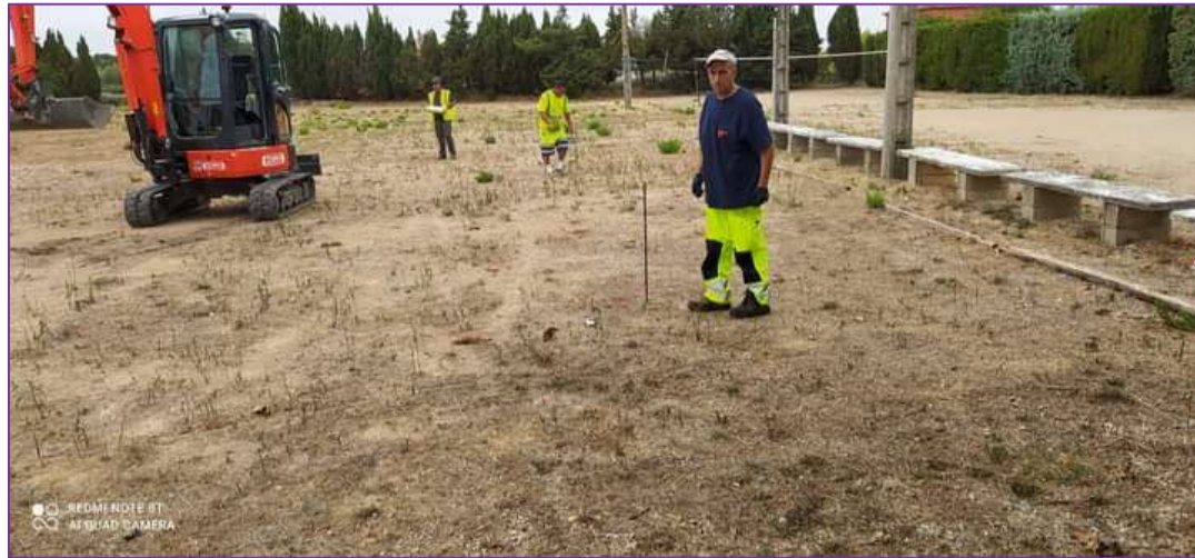
Préparation de la plateforme du City Stade
