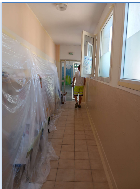
Peinture du couloir de l'école
