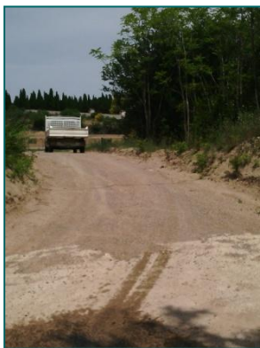
Création d'un accès à la station rue Saint Roch
