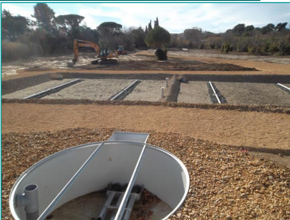
Ne manque que le raccordement électrique pour mettre la station en service
