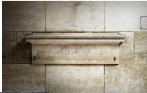
Mètre rue Vaugirard
