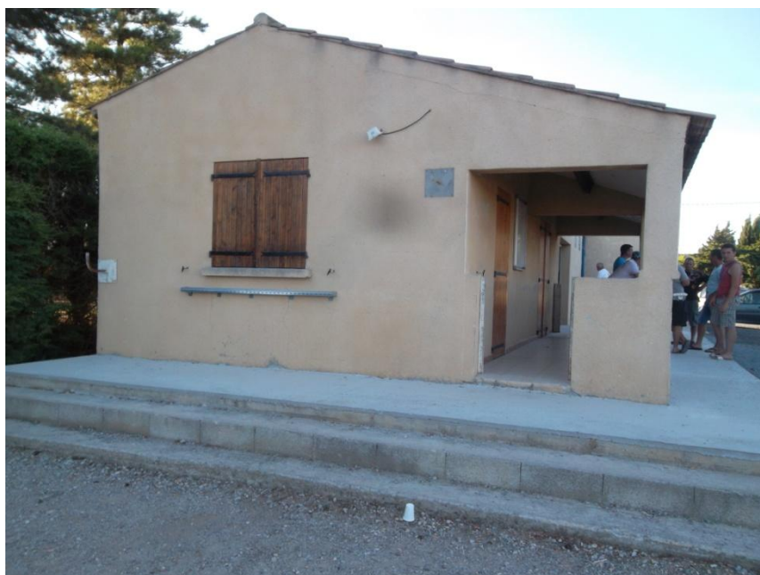
Le seuil de l'accès au club house de pétanque cimenté
