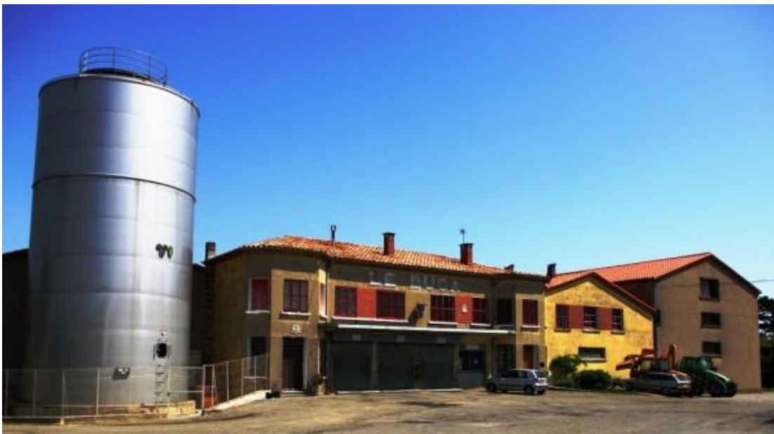
Le Buga dans son entièreté. On distingue bien au centre la cave primitive avec ses deux pavillons, à sa droite le 2 e agrandissement peint en jaune, à droite encore le 4 e agrandissement qui ne se terminera pas et à gauche le vinificateur inox qui masque le 3 e bâtiment
