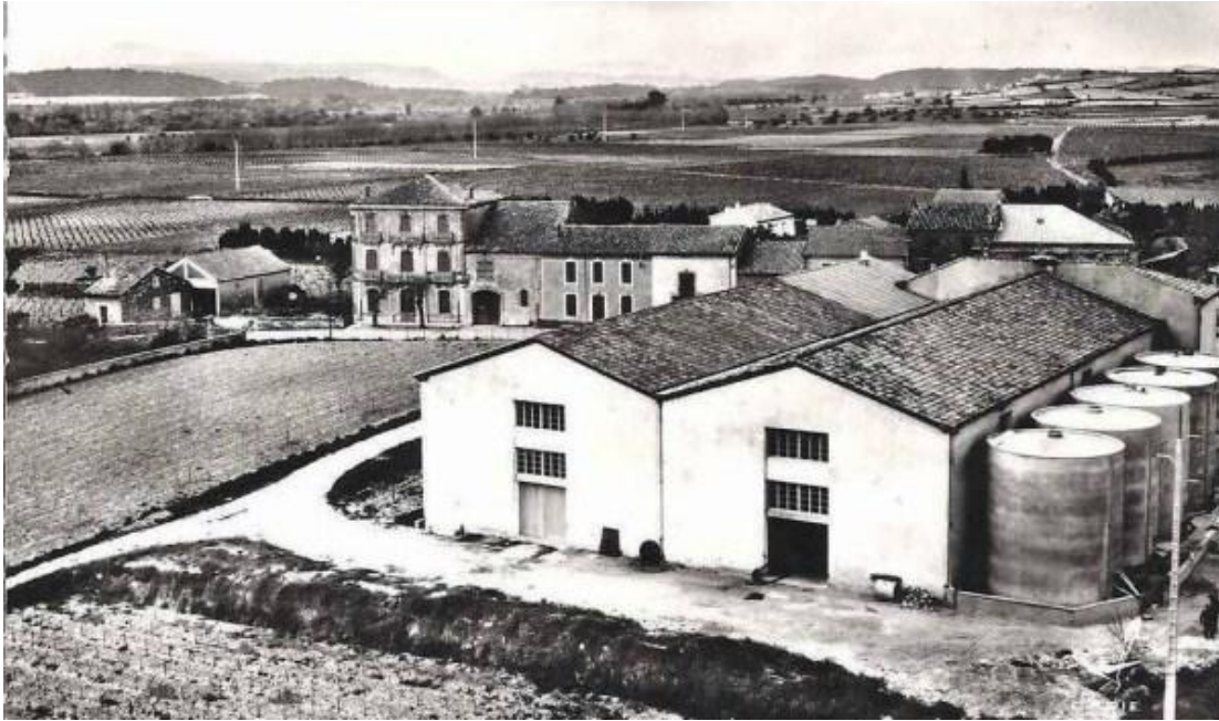
Une ancienne vue de l'arrière de la cave. Le 3 e agrandissement est en cours de construction, on aperçoit bien les cuves cylindriques qui seront ensuite enserrées dans un bâtiment
